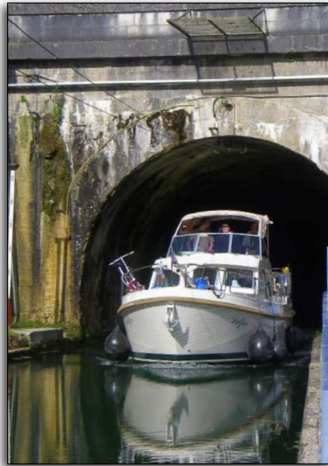
"...le tunnel de Demange à Mauvages..."
